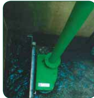
Channel Monster с удлиненным валом привода.
