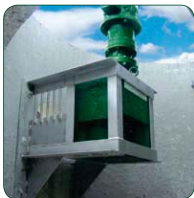
Mini Monster установленный в насосной станции
