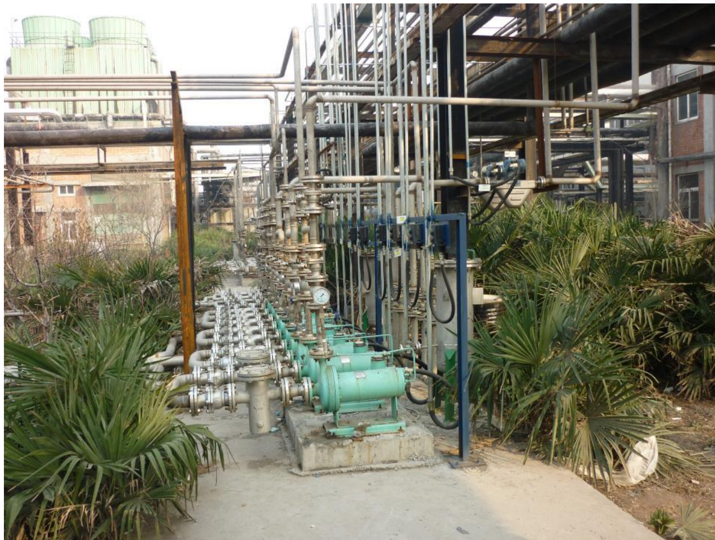
Насосы основного типа для производства химического волокна (Малайзия)
