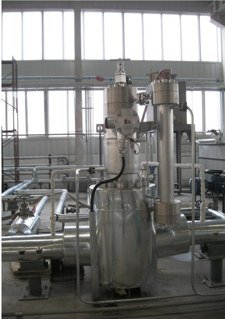
Насос серии НТ на высокое давление и температуру. Атомная станция (КНР)
