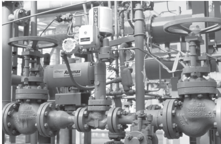
Клапан Guardian II Ду = 2" на химическом заводе
