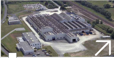
Анжи / Западная Франция Технический центр, РСМ
