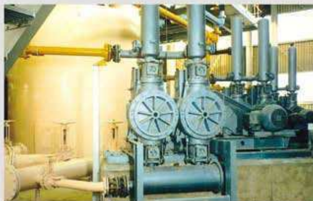
SG 50/130 - K 220 - 2 SM 460 Q = 40 \text{ m}^3/\text{h} p = 17,5 \text{ bar} P = 30 \text{ kW} Среда: цементный шлам
