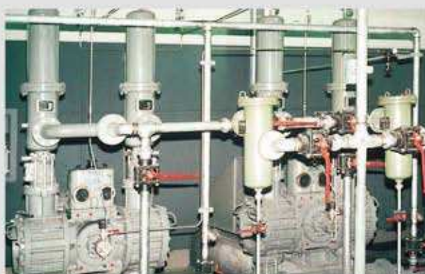
SG 50/130 - K 140 - SM 350 ZW Q = 8 \text{ m}^3/\text{h} p = 25 \text{ bar} P = 11 \text{ kW} Среда: известь + зола
