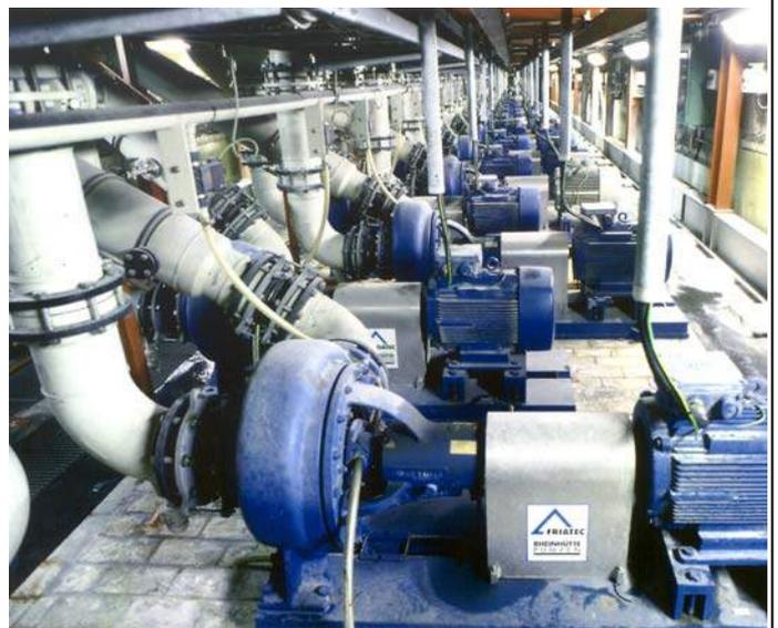
Chemie-Normpumpen Typ RN in der elektrolytischen Verzinkungsanlage eines Kaltwalzwerkes.
